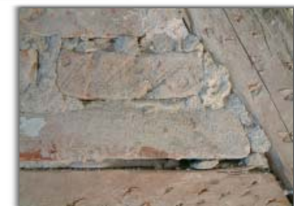
Mauerziegel mit Sägezahnmuster aus der Bauphase um 1560 in einer Fachwerkwand des Obergeschoßes
